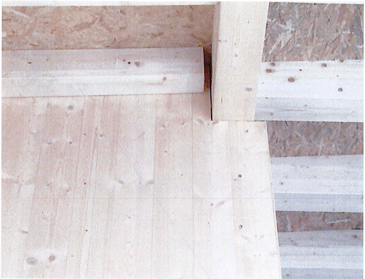
foto nr.3 - mancanza raffittimento viti del travetto ausiliario
